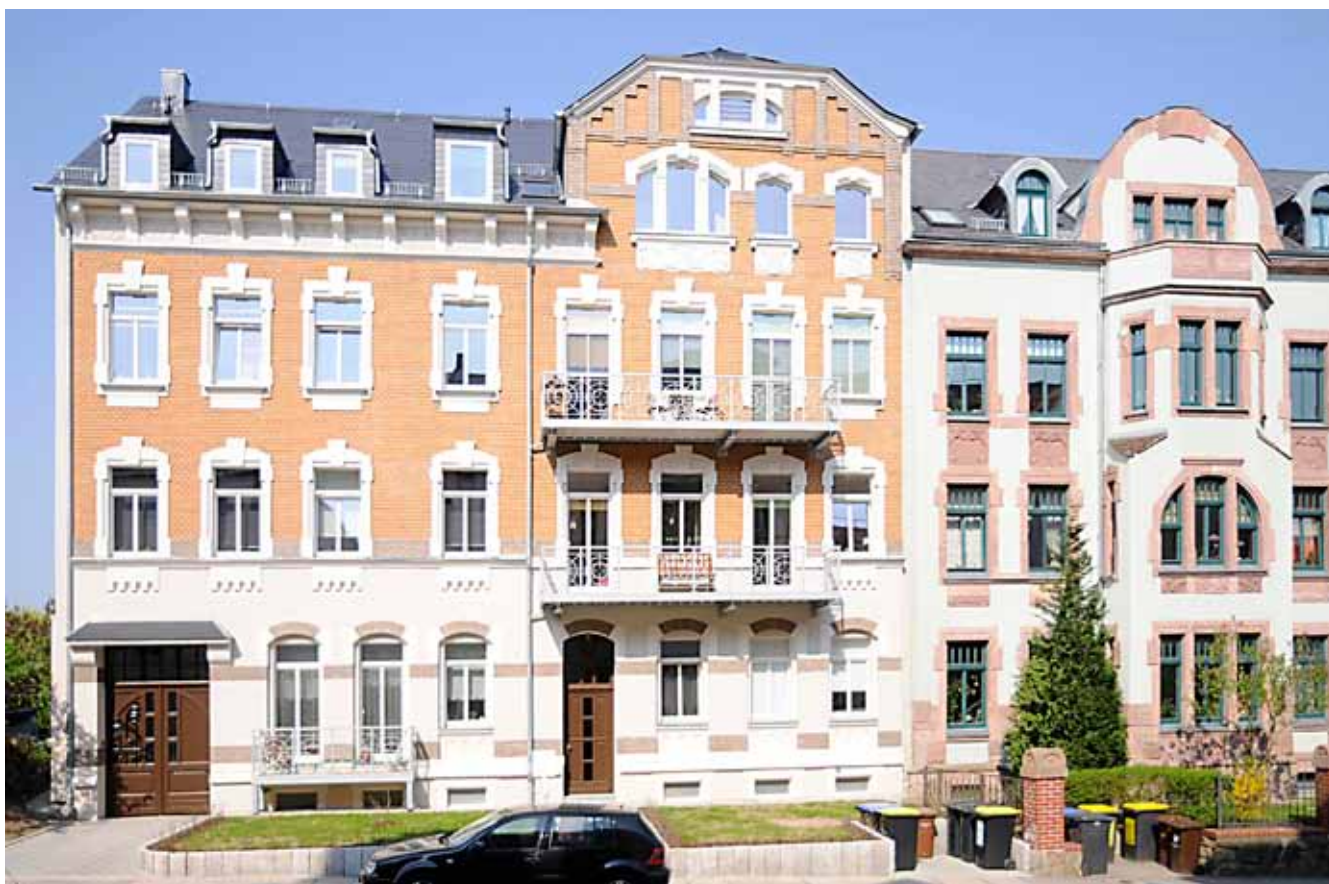
Referenzobjekt in der Hofer Straße
