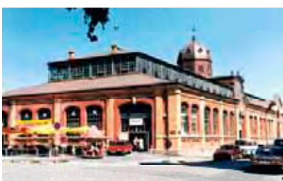
Markthalle – typisches Beispiel für die anspruchsvolle Architektur im Gewerbebau
