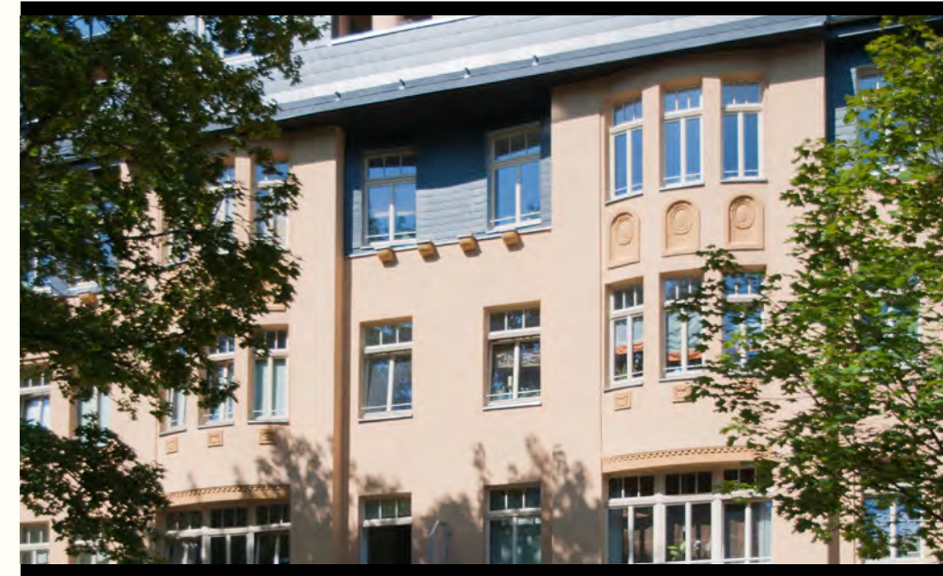
Further Straße, Chemnitz
